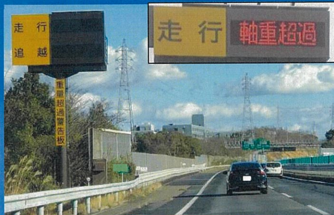
高速道路本線での「軸重超過」表示
